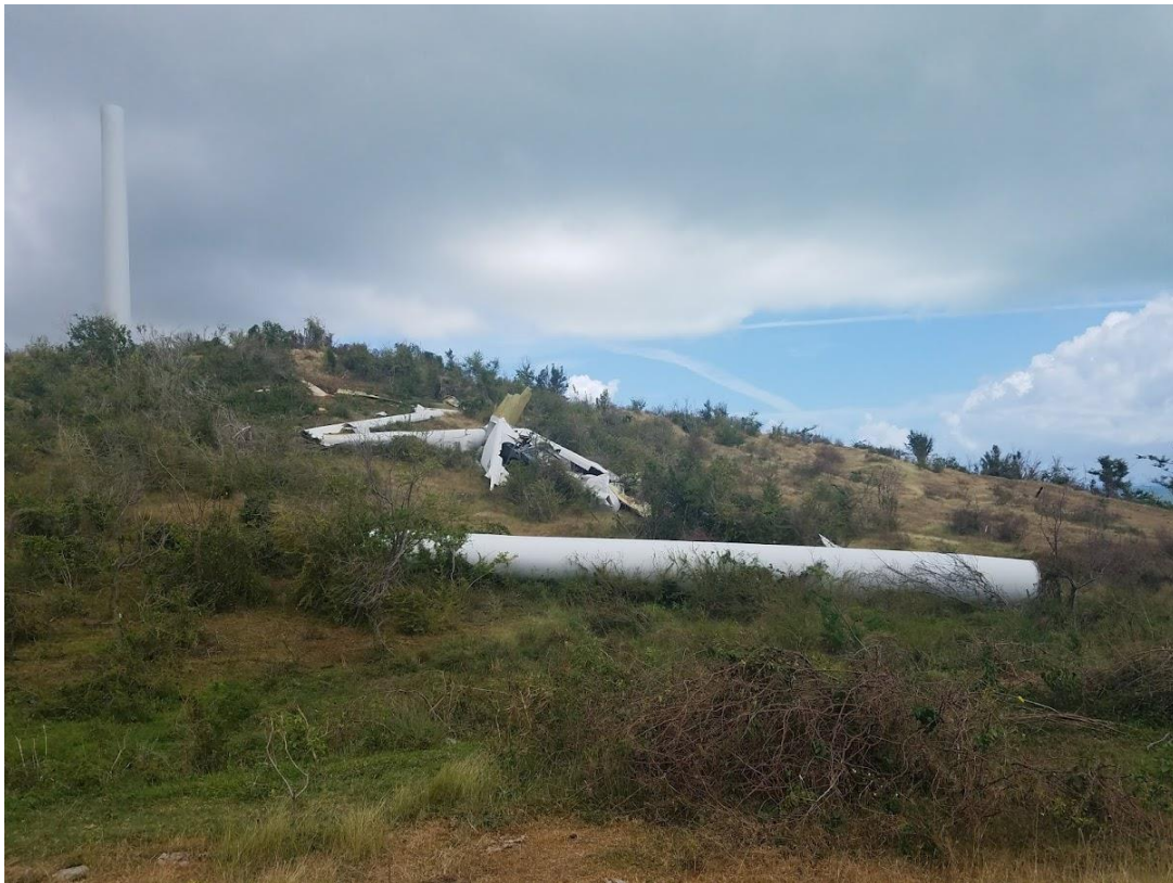
Figura 25 – Turbinas eólicas inoperables y averiadas en el parque eólico Punta Lima luego del paso del huracán María por Naguabo, Puerto Rico
